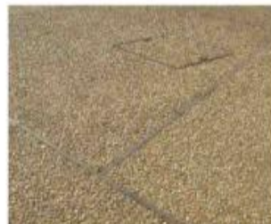
Pavimentazione in cls
